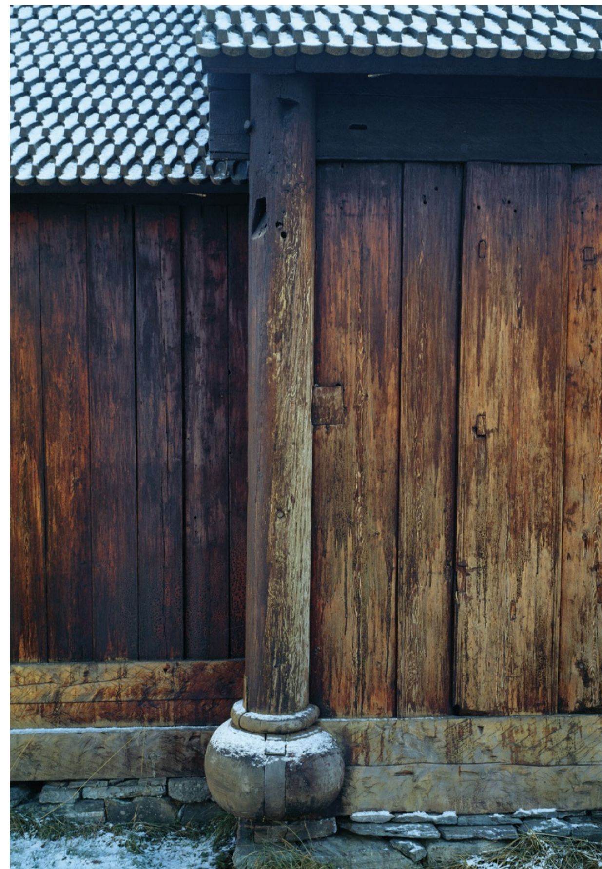
Stabkirche, Haltdalen, Eckstütze
